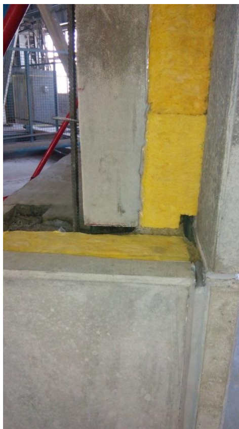
Узел сопряжения панелей.
